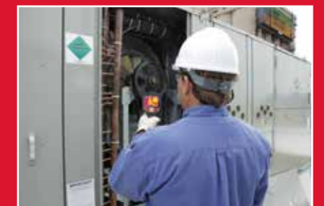
Para diagnosticar problemas em sistemas de arrefecimento
