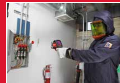
Para diagnosticar problemas em armários de ligações elétricas
